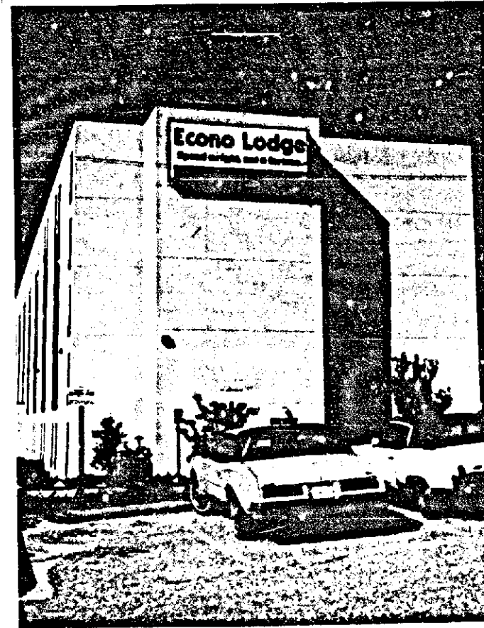
F. Sign on SE/S of Bldg.
