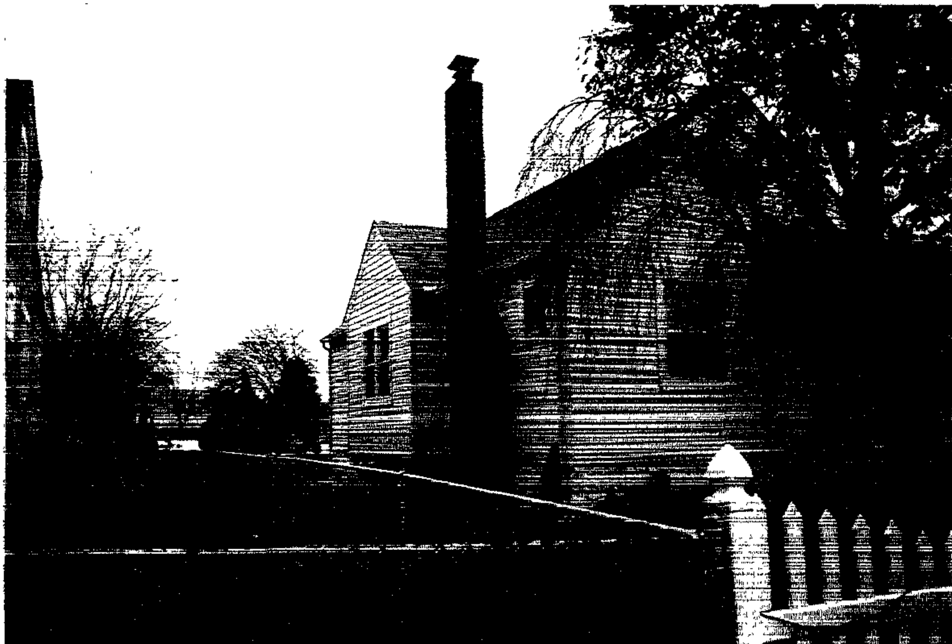
SIDE OF 205 S. TAYLOR AVE
