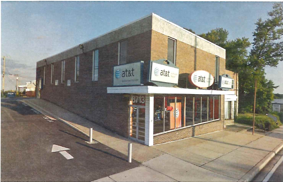
EXISTING CONDITIONS N.T.S.
